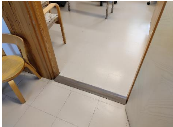
Kuva 5: Tilassa 1004 asbestia sisältävä vinyylilaatta ja käytävässä muovilaatta, joka ei sisällä asbestia
